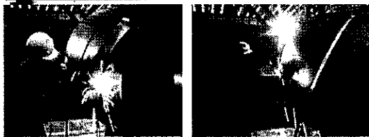
立型鋼板切割面部保持距離 分段切割人員最後遠離
